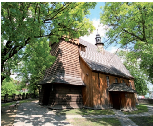
Tarnów - kościół pw. Najświętszej Marii Panny „na Burku” – poświęcony w 1440 r. Wzniesiony w duchu gotyckiej architektury drewnianej. W ołtarzu głównym znajduje się łaskami słynący obraz Matki Bożej z Dzieciątkiem z XVI w.
