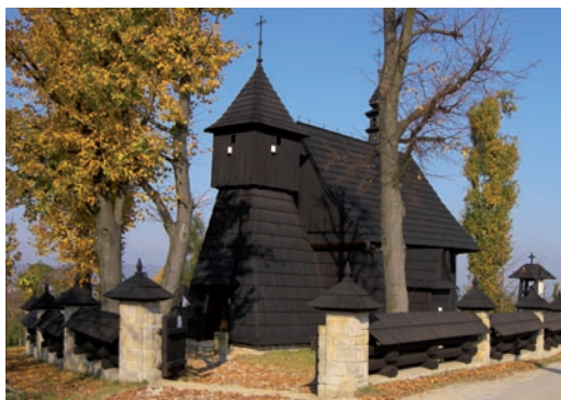
Rzepiennik Biskupi - kościół pw. św. Jana Chrzciciela - zbudowany prawdopodobnie w 1494 r. Najmniejszy i zarazem jeden z najcenniejszych drewnianych kościołów w Małopolsce z pierwotnym układem przestrzennym niezmiennym od średniowiecza. Zachowały się ponadto trzy gotyckie portale wejściowe zamknięte łukami, tzw. oślim grzbietem.
